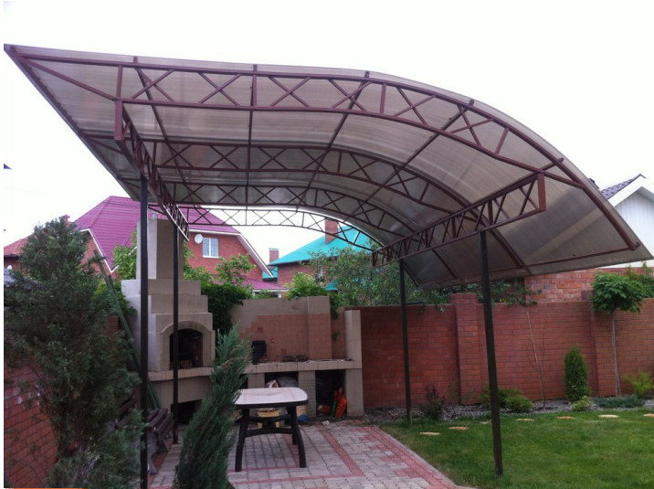
Односкатный навес с усиленной фермой
